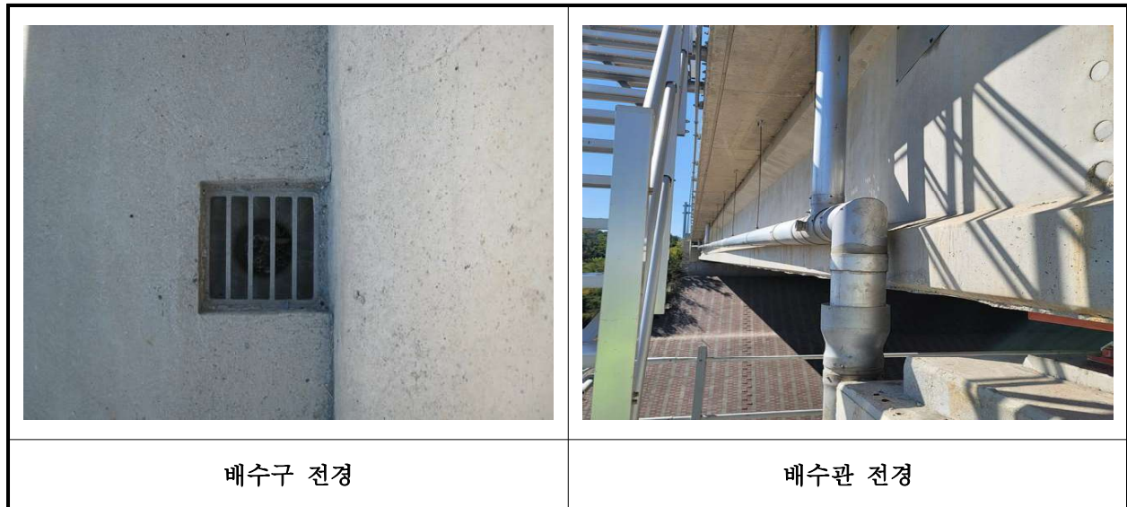
【사진 8.3.21】 배수시설 전경
