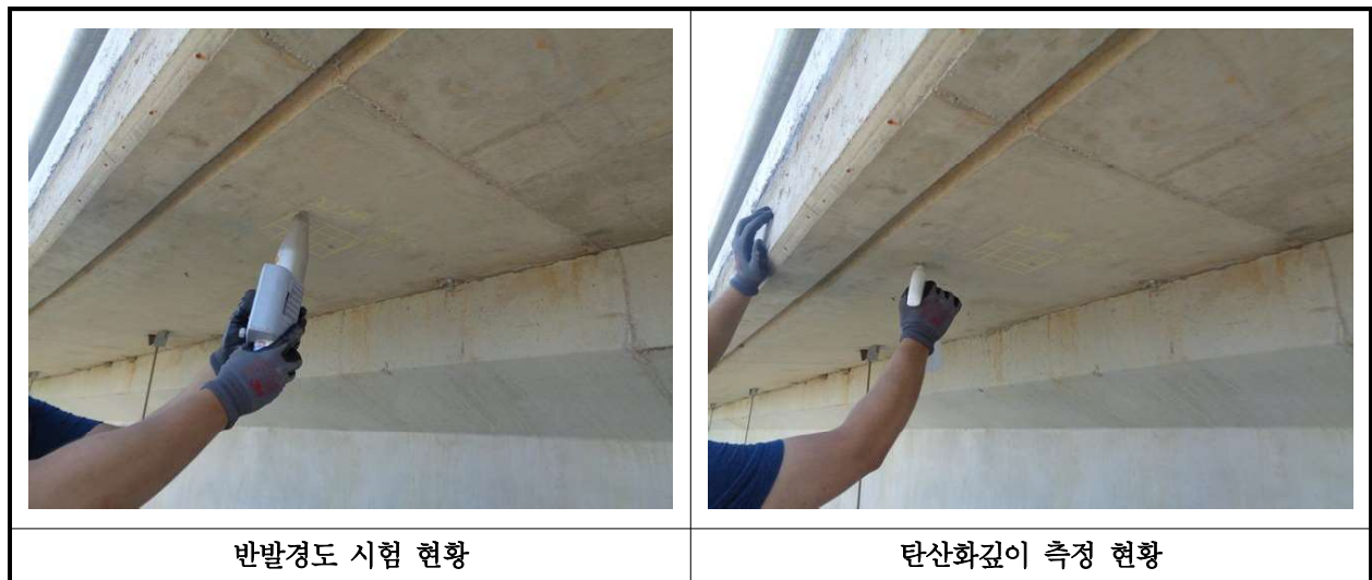
【사진 8.4.1】 콘크리트 내구성조사 현황
