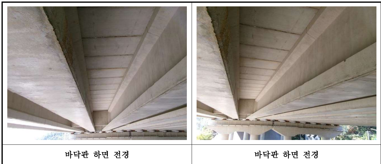
【사진 8.3.2】 바닥판하면 전경
