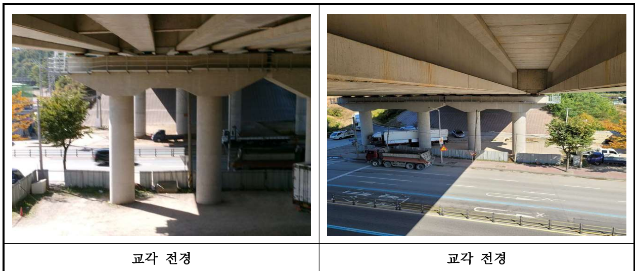
【사진 8.3.10】 교각 전경
