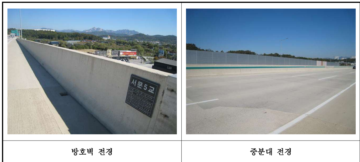
【사진 8.3.23】 방호벽 및 중앙분리대 전경
