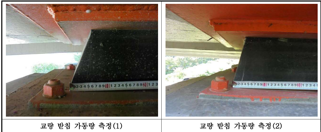
【사진 8.3.15】 교량받침 이동량 측정
