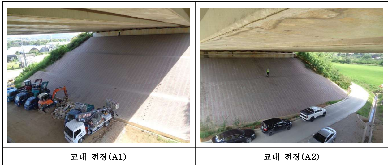
【사진 8.3.8】 교대 전경
