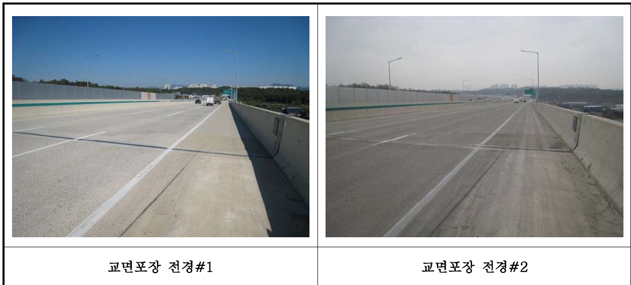
【사진 8.3.19】 교면포장 전경
