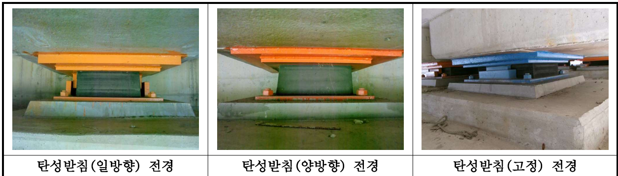
【사진 8.3.12】 교량받침 전경
