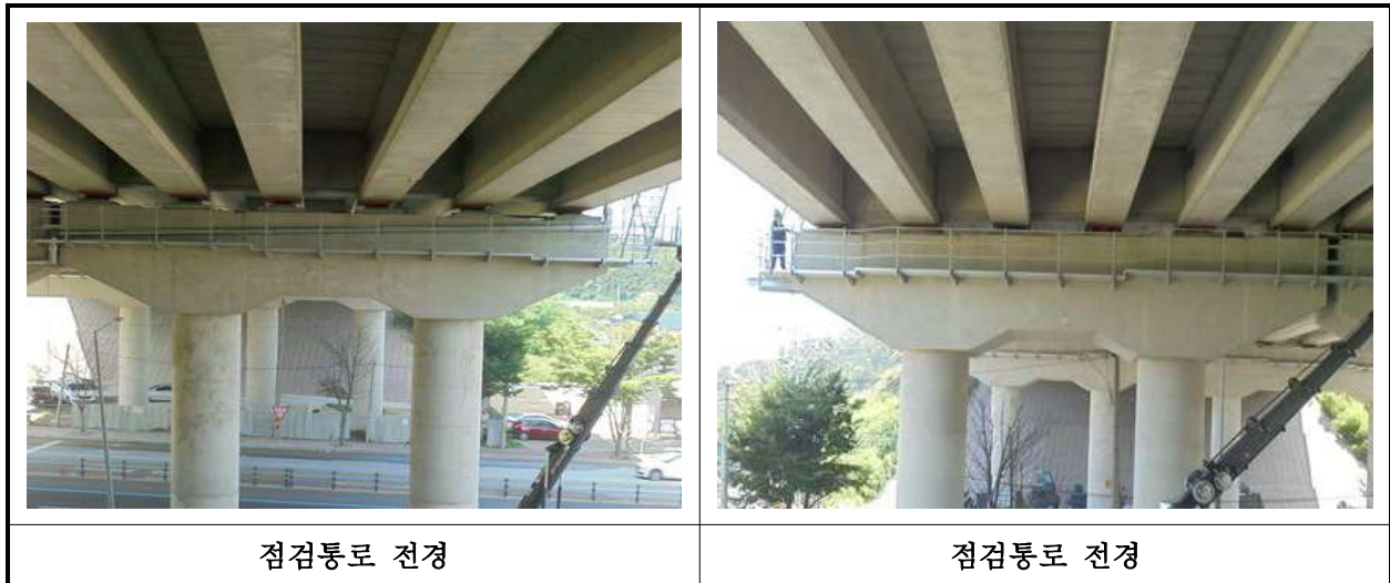
【사진 8.3.25】 교량 점검시설 전경
